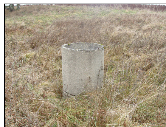
Foto 6 – Kontrolní šachta na zatrubnění Dvorečského potoka
