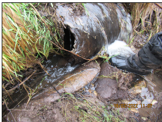
Foto 19 – Potrubí na hlavním toku (azbestocement)
